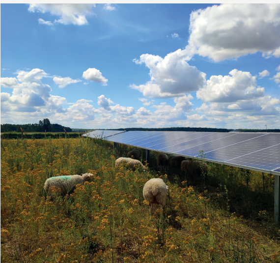
Une réalisation agrivoltaïque de VALOREM dans l'Aube, le parc de Lassicourt, avec l'installation d'un pâturage ovin.
