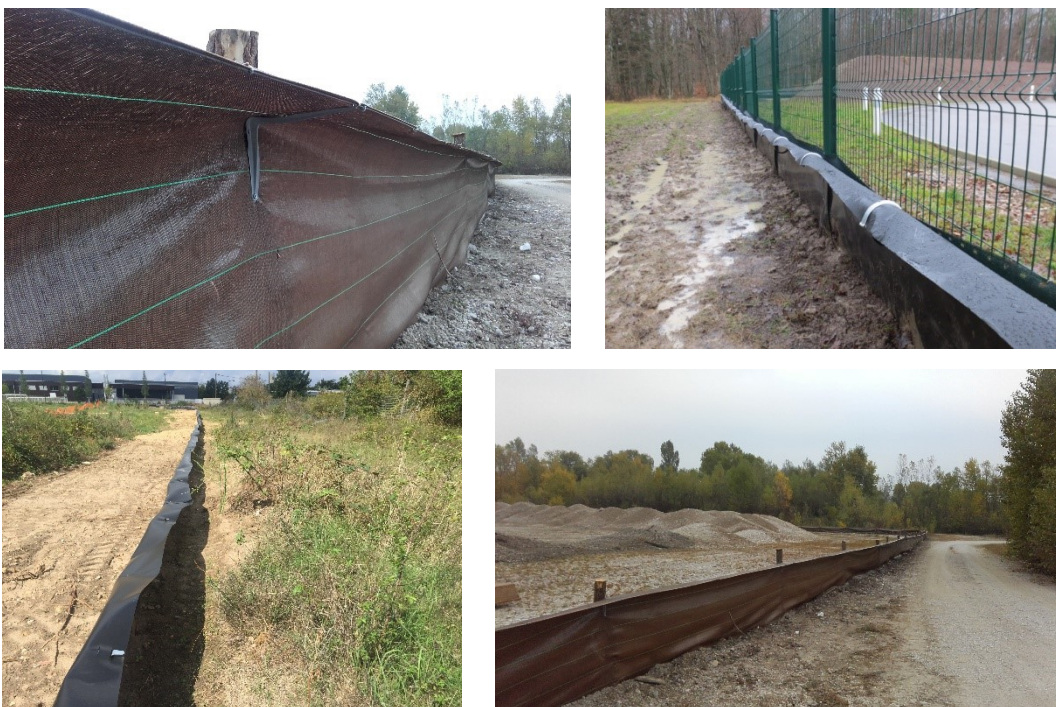
Figure 22 : Exemple de membrane installée avec système anti-retour (photos Écosphère)
