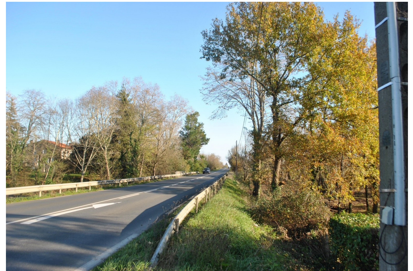
Figure 4 : Passage du Petit Rieu (RD6089) en direction de Montpon-Ménéstérol (source : VALOREM, 2021)
