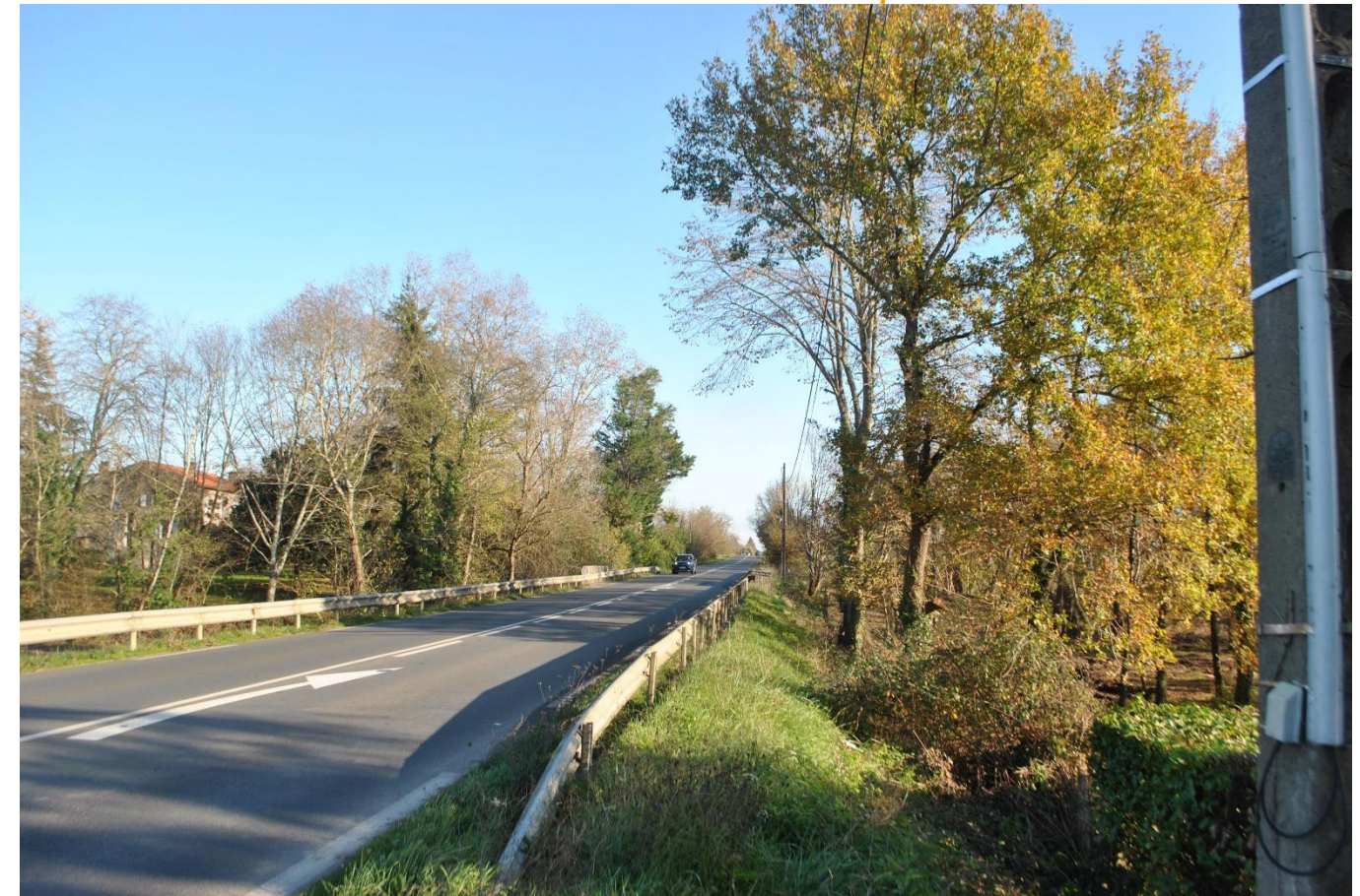
Figure 24 : Passage du Petit Rieu (RD6089) en direction de Montpon-Ménéstérol
