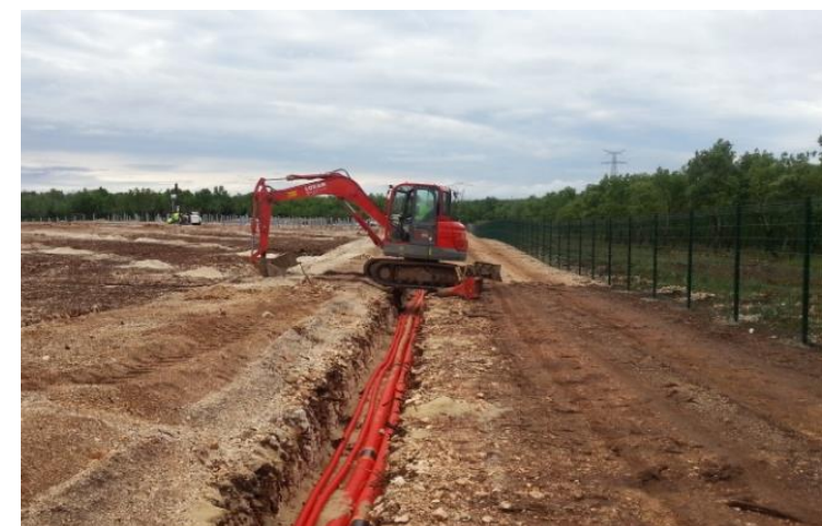
Figure 49 : Illustration de l'enfouissement d'un réseau électrique
