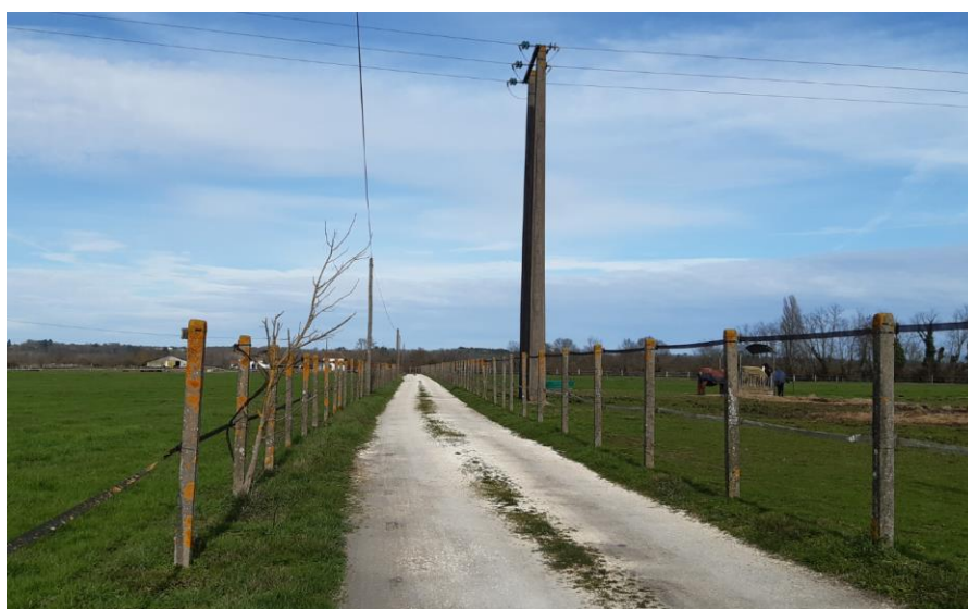
Figure 47 : Photographie de la piste interne à renforcer (chemin d'accès existant)
