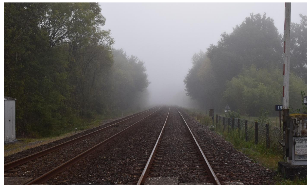
Figure 33 : Voie de chemin de fer à Ménéstérol (source : ATER Environnement, 2020)
