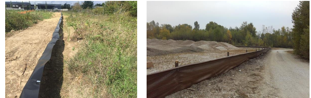
Figure 65 : Exemple de membrane installée avec système anti-retour (photos Écosphère)
